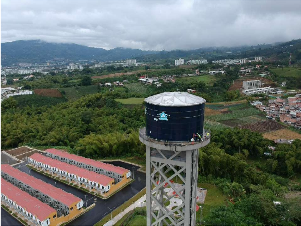
Tanque La Giralda N° 3 (ampliación 1500 metros cúbicos en 2021)
